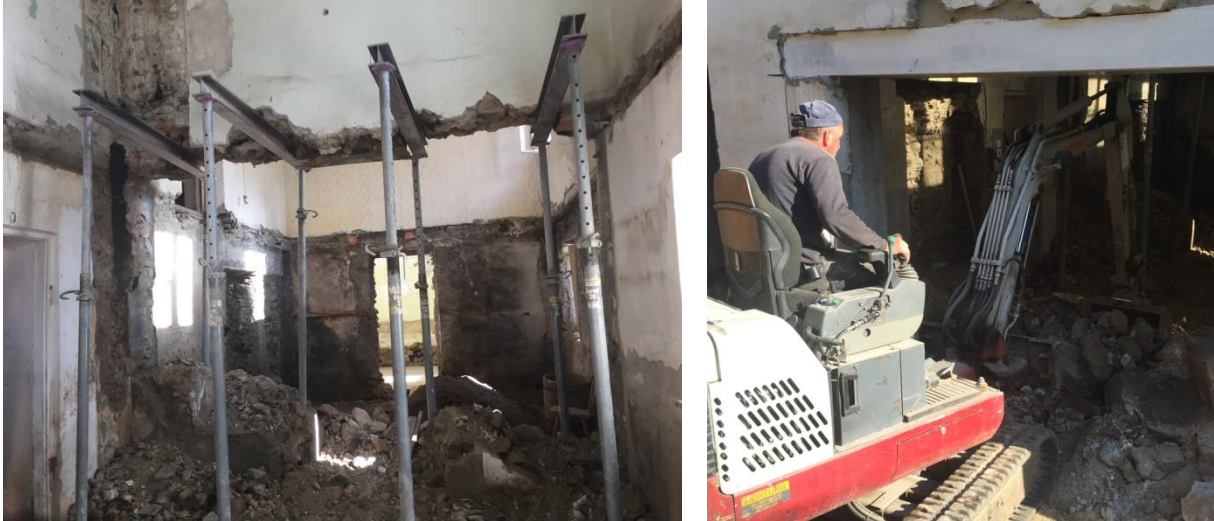
Abbildung 8-9: Unterfangungen und Aushubarbeiten mit hohen Bauschuttmengen
