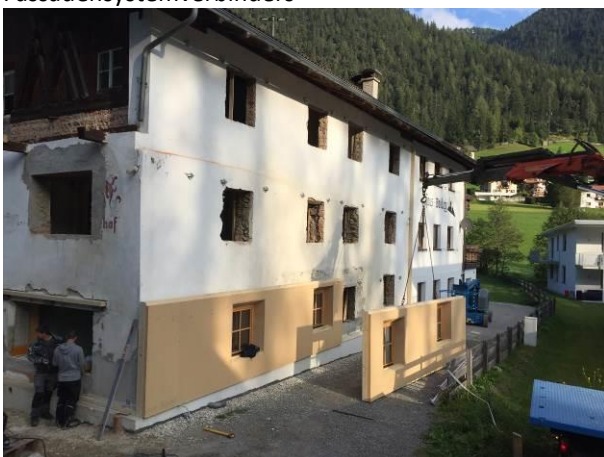
Abb. 17: Montage des zweiten Fassadenelementes
