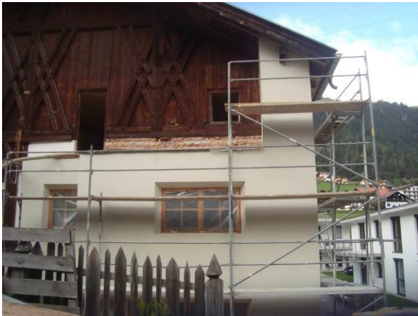
Abb. 51: Ansicht Ostfassade mit Unterputz
