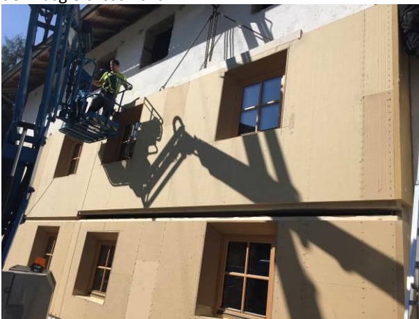
Abb. 27: Montage des vierten Fassadenelementes
