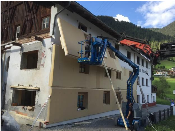
Abb. 29: Montage des fünften Fassadenelementes, mit einem von unten hochgedrückten Fassadenelement zum Einheben unter das Vordach
