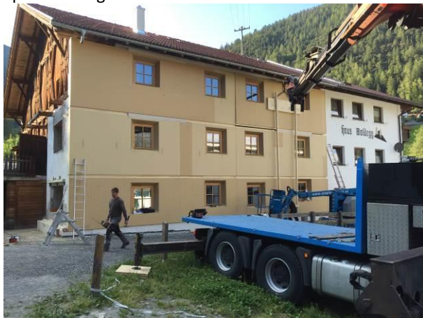
Abb. 33: Montage des sechsten Fassadenelementes
