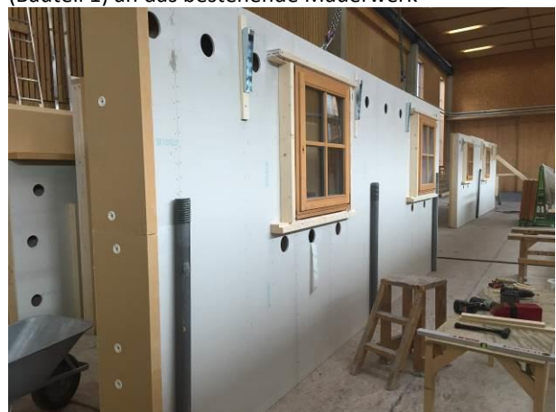
Abb. 6: Vorfertigung der Fassadenelemente im Werk, inkl. Fenstereinbau und Einblasen der Zellulose und Montage des E.T.-Fassadensystemverbinders (Bauteil 2)
