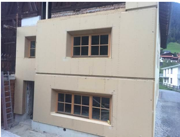
Abb. 39: Ansicht Nordfassade mit „fertig“ montierten Elementen
