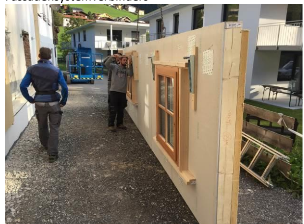
Abb. 18: Voreinstellung der Justierschrauben des E.T.-Fassadenverbinders
