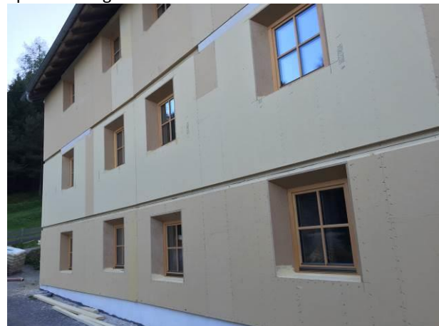
Abb. 34: Ansicht der „fertig“ montierten Ostfassade nach einem Tag
