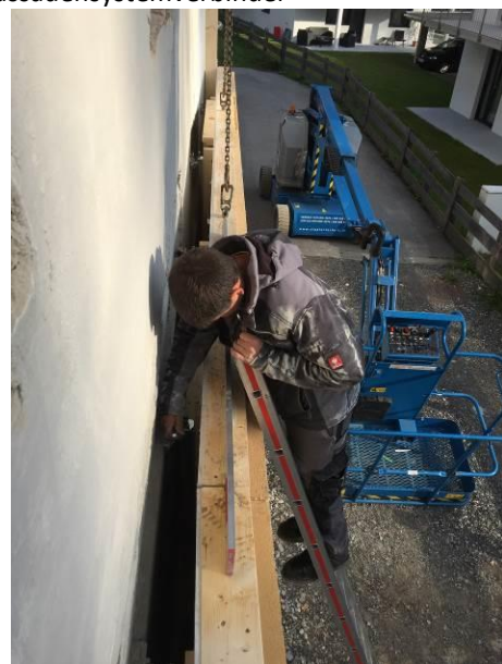
Abb. 24: Justierung und Fixierung der Justierschrauben des E.T.-Fassadensystemverbinders
