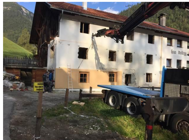
Abb. 12: Montage des ersten Fassadenelementes
