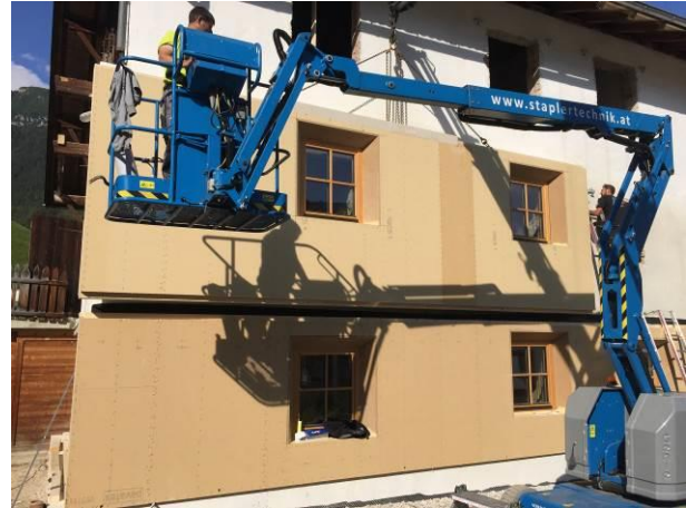
Abb. 26: Montage des dritten Fassadenelementes
