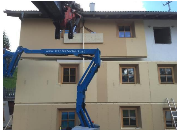
Abb. 30: Einfädeln des fünften Fassadenelementes, Speziallösung zum Einheben unter das Vordach
