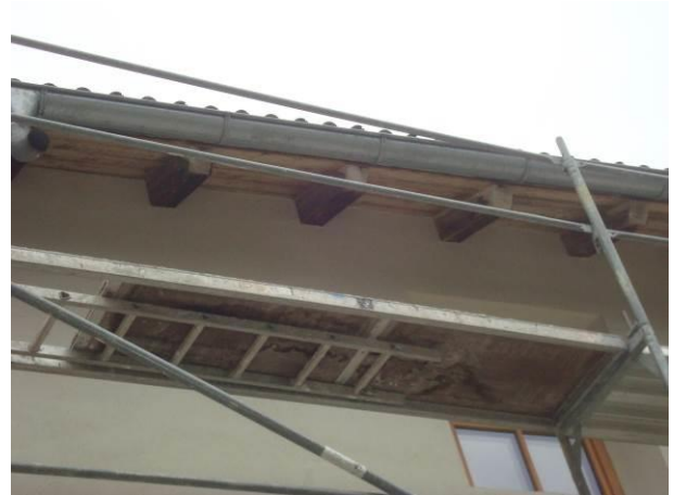
Abb. 50: Anschluss der neuen Fassade an das Vordach
