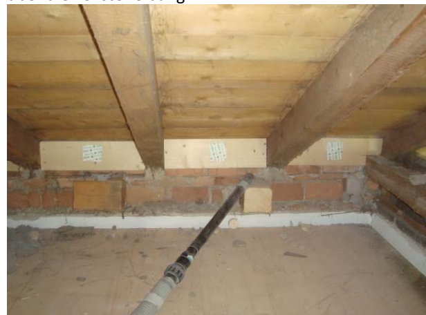
Abb. 48: Einblasen der Zellulose in die Ausgleichsschicht unterm Vordach
