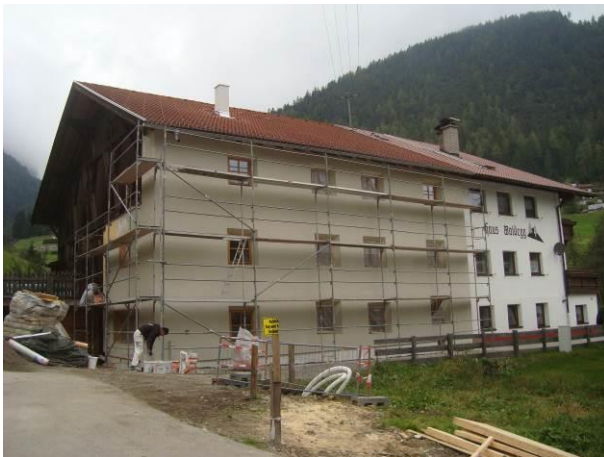
Abb. 41: Aufbringen des Unterputzes
