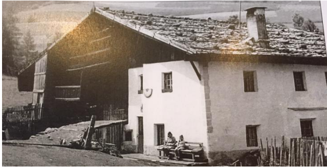
Abbildung 1: alte Ansicht vom Mairhaushof vor 1950
