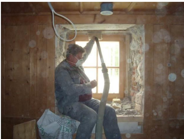
Abb. 47: Einblasen der Zellulose in die Ausgleichsschicht über die Fensterleibung
