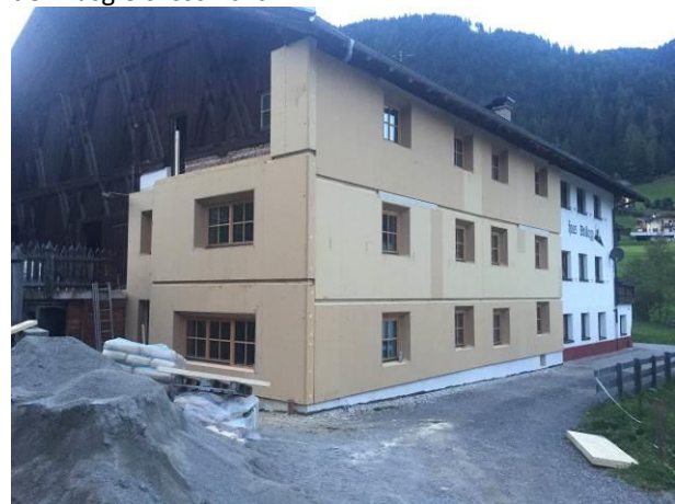
Abb. 40: Ansicht „fertig“ montierte Ost- und Nordfassade
