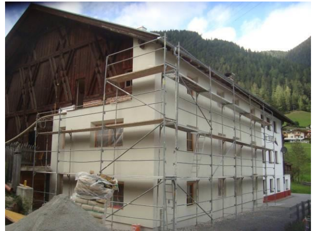
Abb. 52: Ansicht Nord- und Ostfassade mit Unterputz
