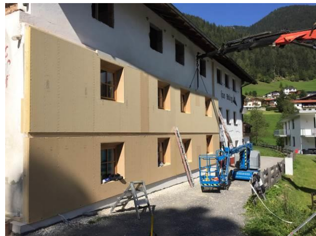
Abb. 28: Montage des vierten Fassadenelementes
