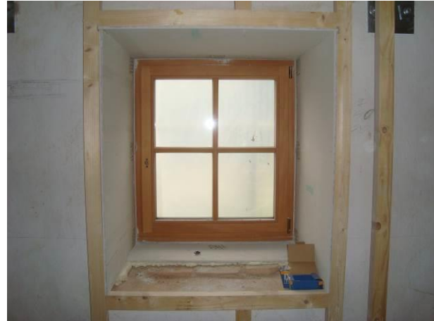
Abb. 44: Ansicht Fensterleibung von innen
