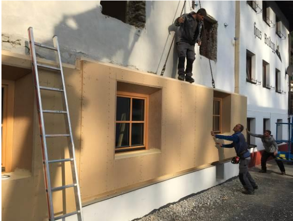
Abb. 19: „Einhängevorgang“ des zweiten Fassadenelementes
