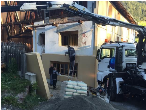
Abb. 37: Montage der Nordfassade, erstes Element
