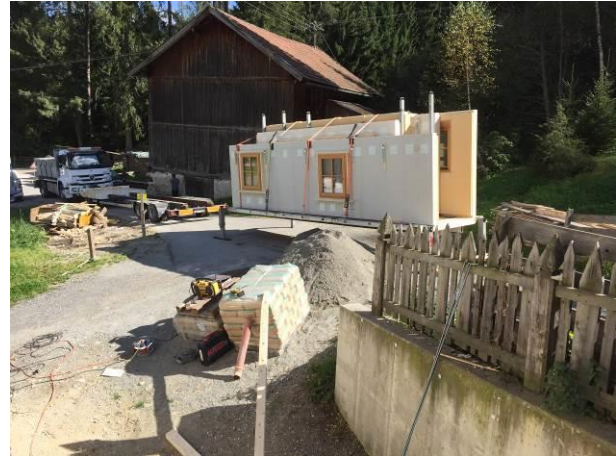
Abb. 8: Anlieferung der vorgefertigten Fassadenelemente auf die Baustelle
