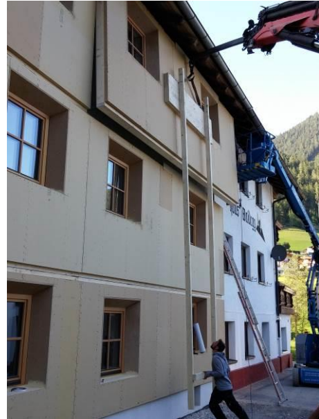
Abb. 32: Montage des sechsten Fassadenelementes, Speziallösung zum Einheben unter das Vordach
