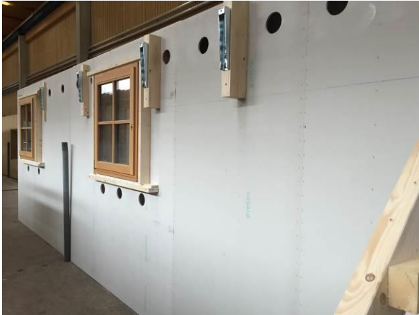
Abb. 7: die unebene Bestandsfassade ( \leq 17 cm!!) wurde mit „Ausgleichshölzer“ bzw. Knaggen hinter dem E.T.-Fassadensystemverbinders ausgeglichen
