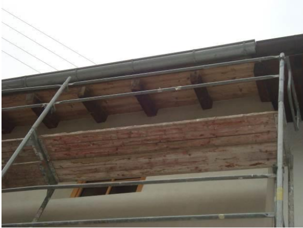
Abb. 49: Anschluss der neuen Fassade an das Vordach
