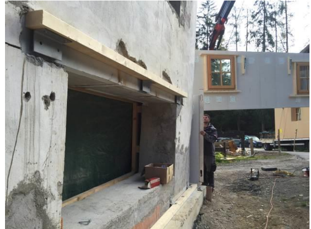
Abb. 14: genaues Ausrichten des ersten Elementes und Vorbereitung des zweiten Fassadenelementes
