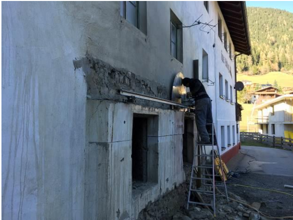
Abb. 1: Entfernung des Mauervorsprungs mit einer Diamantkreissäge
