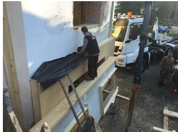
Abb. 38: Abdichtbahn zur geschossweisen Trennung der Ausgleichsschicht
