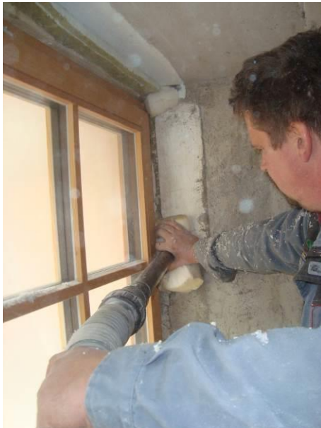
Abb. 45: Einblasen der Zellulose in die Ausgleichsschicht über die Fensterleibung
