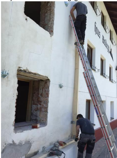
Abb. 9: Montage der Anschlusshölzer bzw. Richthölzer zum Einrichten und Anschließen an den Bestand
