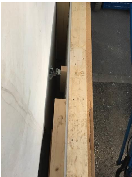
Abb. 23: Blick in die „Ausgleichsschicht“ von oben mit E.T.-Fassadensystemverbinder
