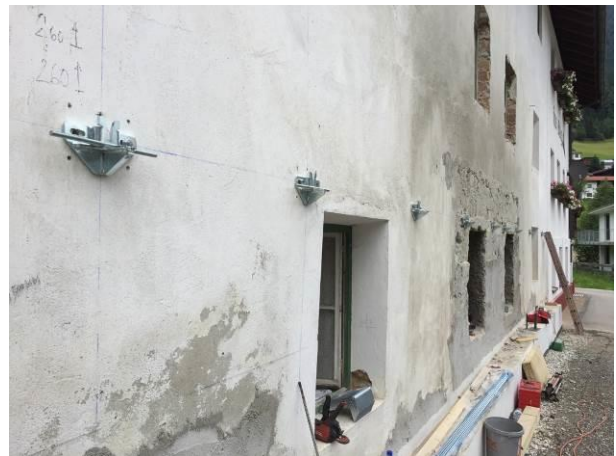
Abb. 4: Montage des E.T.-Fassadensystemverbinders (Bauteil 1) an das bestehende Mauerwerk
