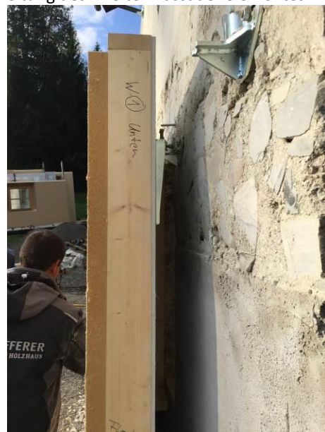
Abb. 16: Anschluss- und Montagedetail des E.T.-Fassadensystemverbinders
