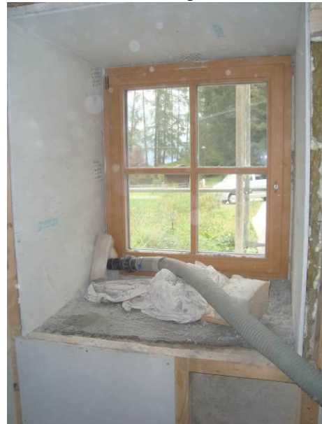
Abb. 46: Einblasen der Zellulose in die Ausgleichsschicht über die Fensterleibung
