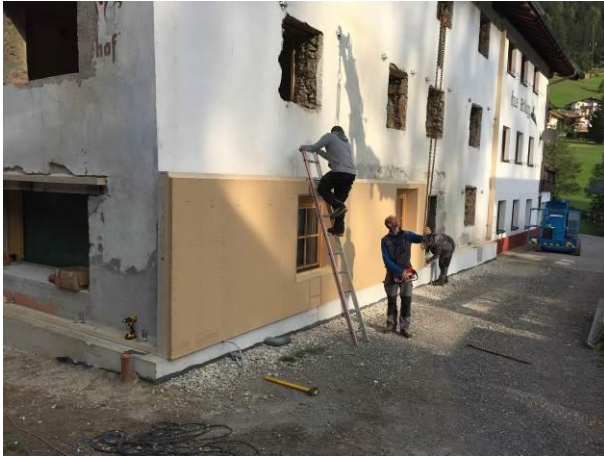
Abb. 13: Montage des ersten Fassadenelementes mit zwei Personen und Kranführer
