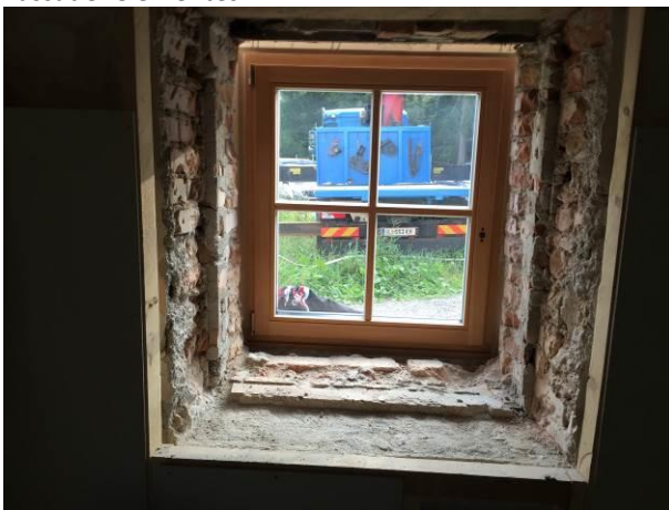
Abb. 21: Ansicht Fensterleibung von innen
