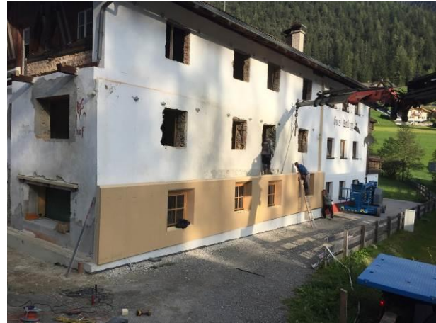
Abb. 20: Das zweite Fassadenelement ist montiert
