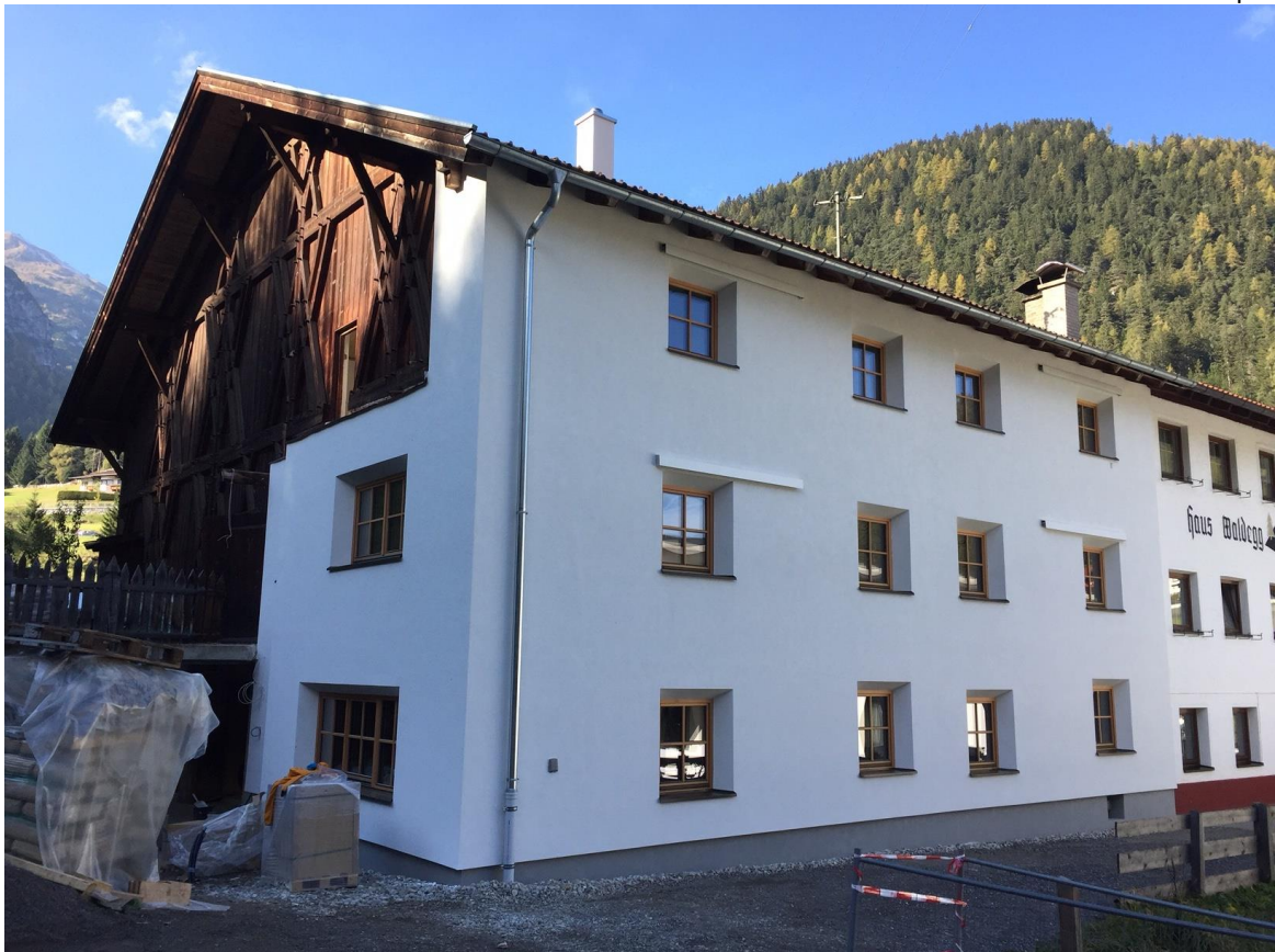
Abb. 53: Ansicht der fertig verputzten Nord- und Ostfassade (es fehlen nur noch die verschiebbaren Fensterläden)
