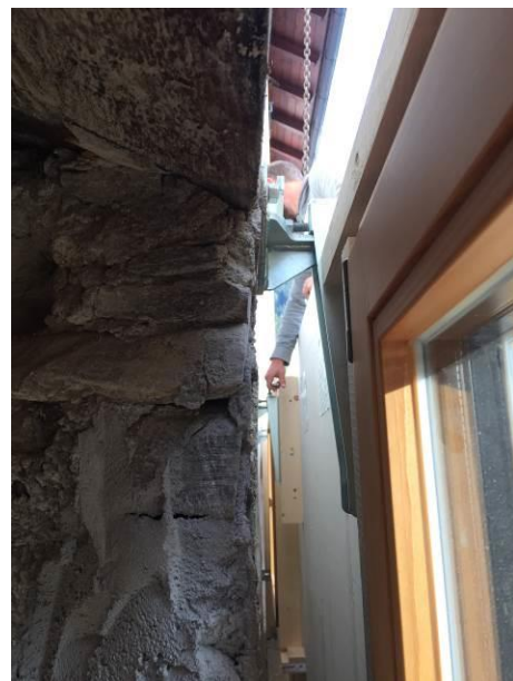
Abb. 22: Blick in die „Ausgleichsschicht“ von innen mit E.T.-Fassadensystemverbinder
