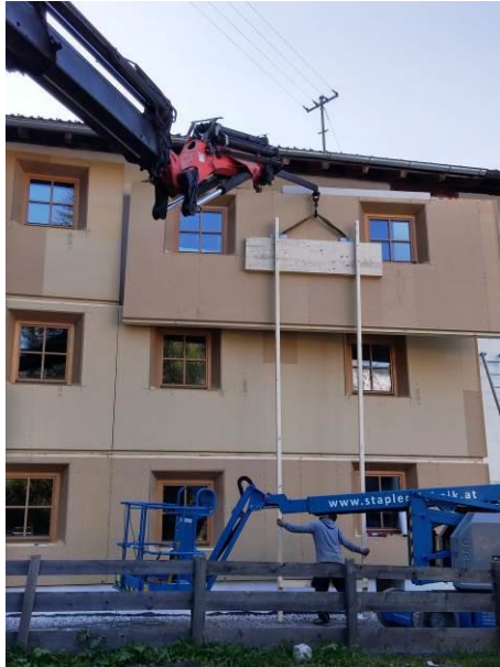
Abb. 31: Montage des sechsten Fassadenelementes, Speziallösung zum Einheben unter das Vordach
