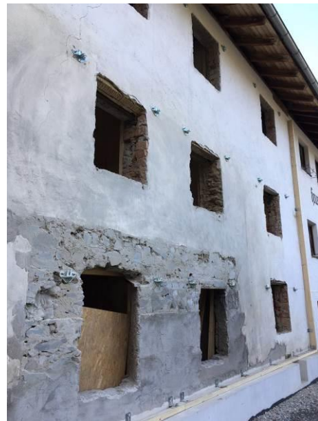
Abb. 10: Ansicht der Bestandsfassade Ost
