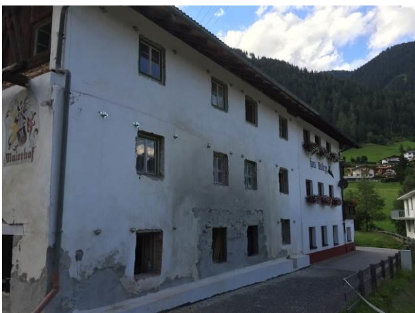
Abb. 5: Ansicht der Bestandsfassade Ost mit den montierten E.T.-Fassadensystemverbindern (Bauteil 1)
