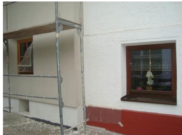
Abb. 42: Anschluss der neuen Fassade an das Nachbarhaus
