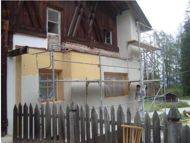
Abb. 43: Aufbringen des Putzsystems
