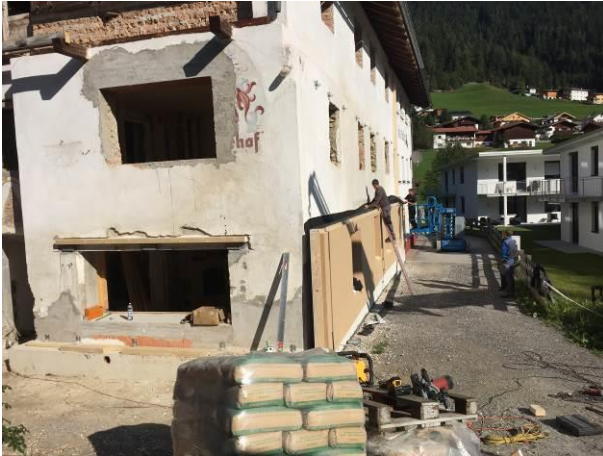
Abb. 25: Abdichtbahn zur geschossweisen Trennung der Ausgleichsschicht
